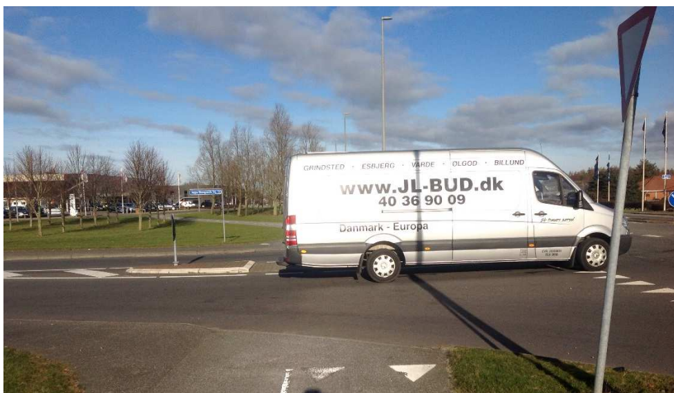
Figur 4 Eksisterende stikrydsning ved dobbeltrettet cykelsti, hvor den afventende trafik på Jeppe Skovgaards Vej blokerer for krydsningen.
